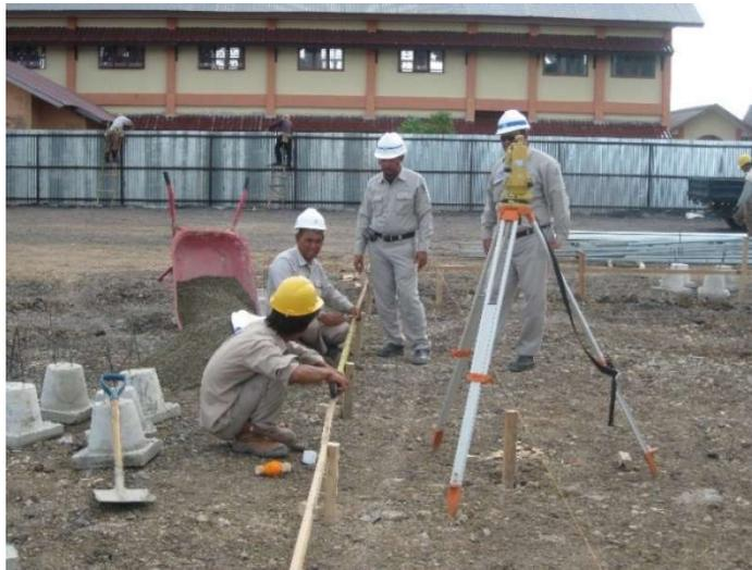
**Gambar 9.** Pemasangan Bouwplank
